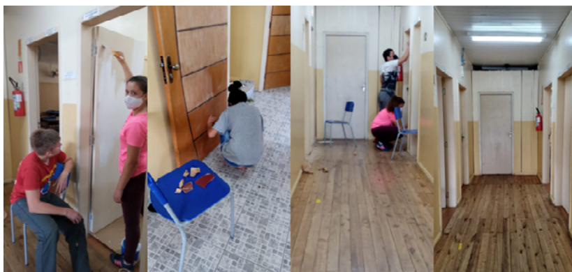
Figura 2 – Processo de lixamento a aplicação de fundo branco
