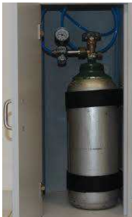
Figura 2: Roliço de ferro com regulador de compressão
